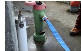
2. Anschluss Trinkwasserschlauch Storz 55 an den Hydranten.
