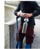
3. Anschluss Druckvernichter an Trinkwasserschlauch Storz 55.
